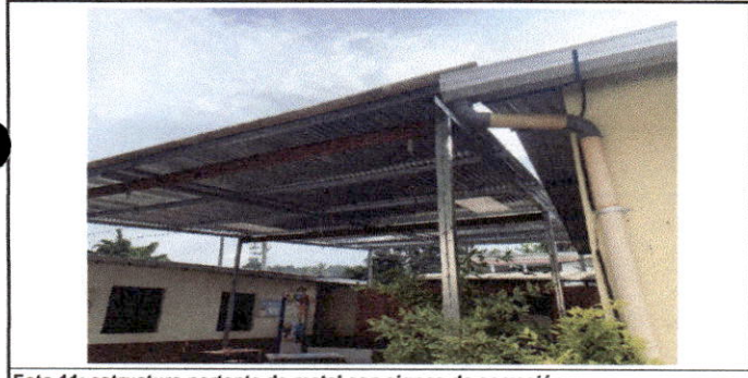
Foto 11: estructura portante de metal con signos de corrosión.
