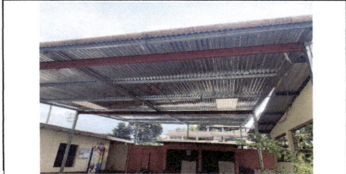
Foto 9: Láminas en el techado del patio lateral.
